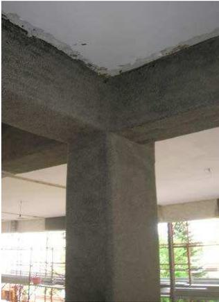
Fig. 14 rinforzi per modificare il meccanismo di rottura
