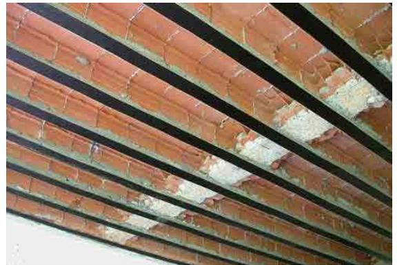
Fig. 17 rinforzi taglio flessione di solaio in latero cemento
