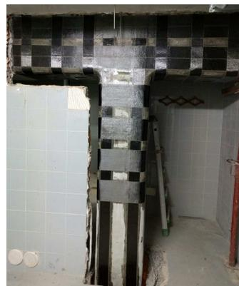
Fig. 13 rinforzo nodo-trave pilastro
