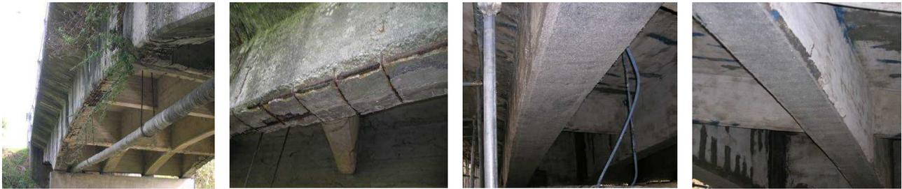
Fig. a: ponte inagibile per evidente degrado del calcestruzzo strutturale
