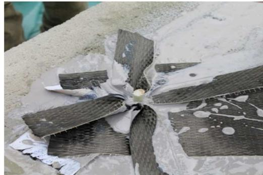
Fig. 20 Connettore Ardfix
