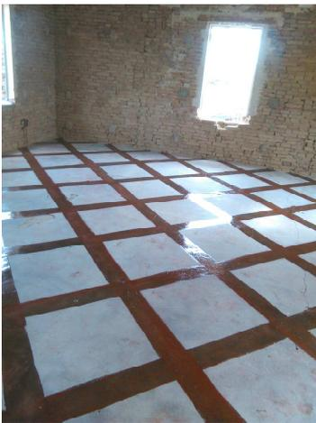
Fig. 18 rinforzo solaio al fine di creare un piano rigido
