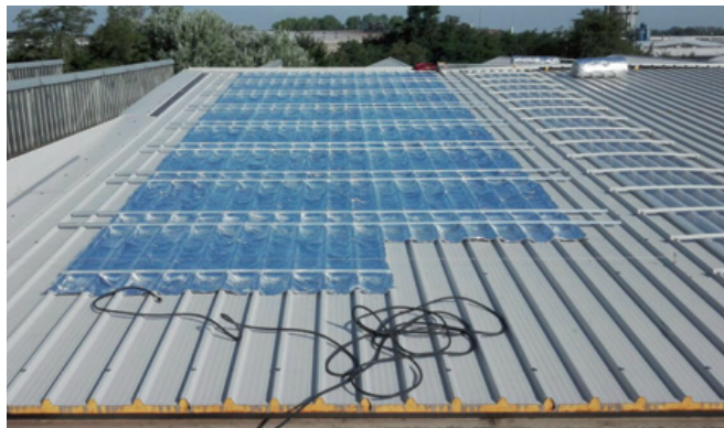
Over-foil Nest come strato ignifugo sotto pannelli fotovoltaici
