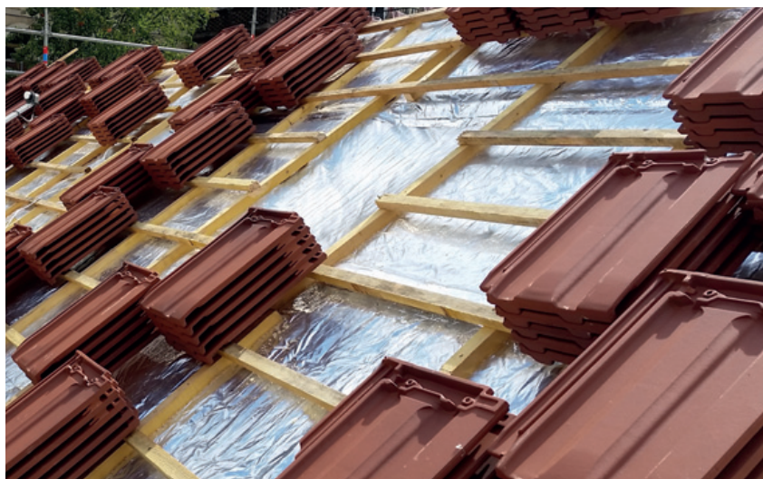
Isolamento di coperture
