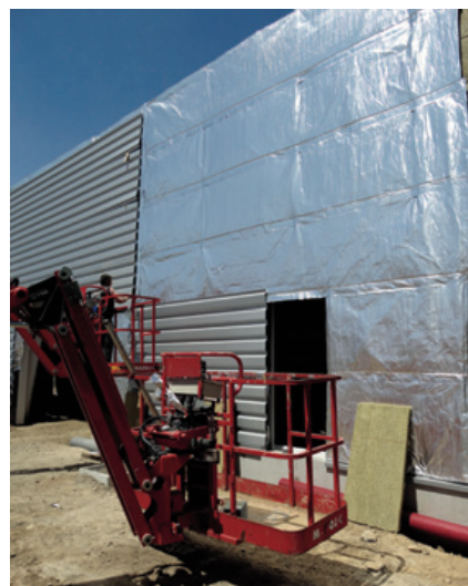
Isolamento di pareti ventilate
