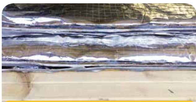
1 - Primo e secondo strato di Over-foil Multistrato 19
