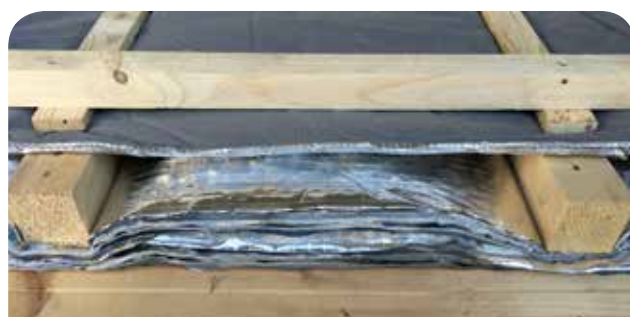
4 - Posa listelli scorrimento acqua e porta tegole
