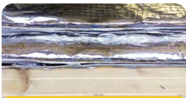
1- Primo e secondo strato di Over-foil Multistrato 19
