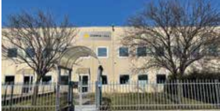
Sede e deposito - Via Monte Grappa - Arese
