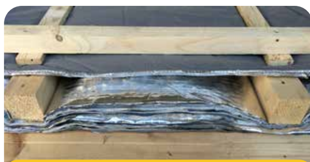
4 - Posa listelli scorrimento acqua e porta tegole
